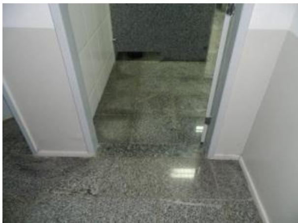
**Figura 33.** Pequeno degrau entre o corredor e o acesso ao banheiro. Nota-se a falta de sinalização. Fonte: ASCOM/FAMAZ, 2013.
